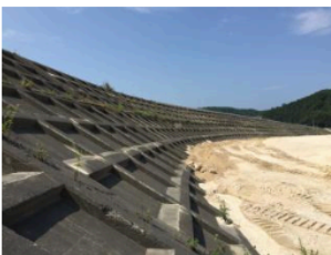
地上高7.7の第一防潮堤（2015年8月現在）
