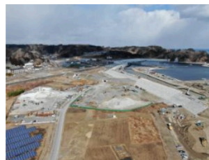
上空から防潮堤を見下ろす（2021年2月現在）
