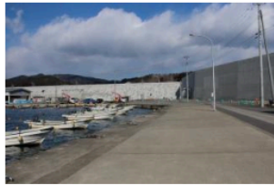
港からの防潮堤
