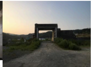
一部破壊されて残された旧防潮堤通路（2015年8月現在）
