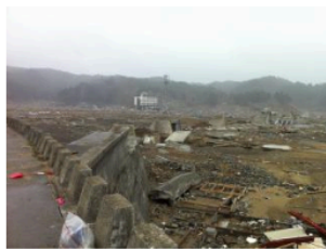
東日本大震災津波による街の被災状況（2011年4月現在）
