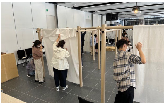
間仕切りシステムの組み立て
