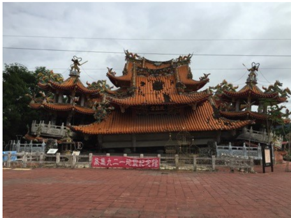
地震により倒壊した武昌宮（遺構として保存）
